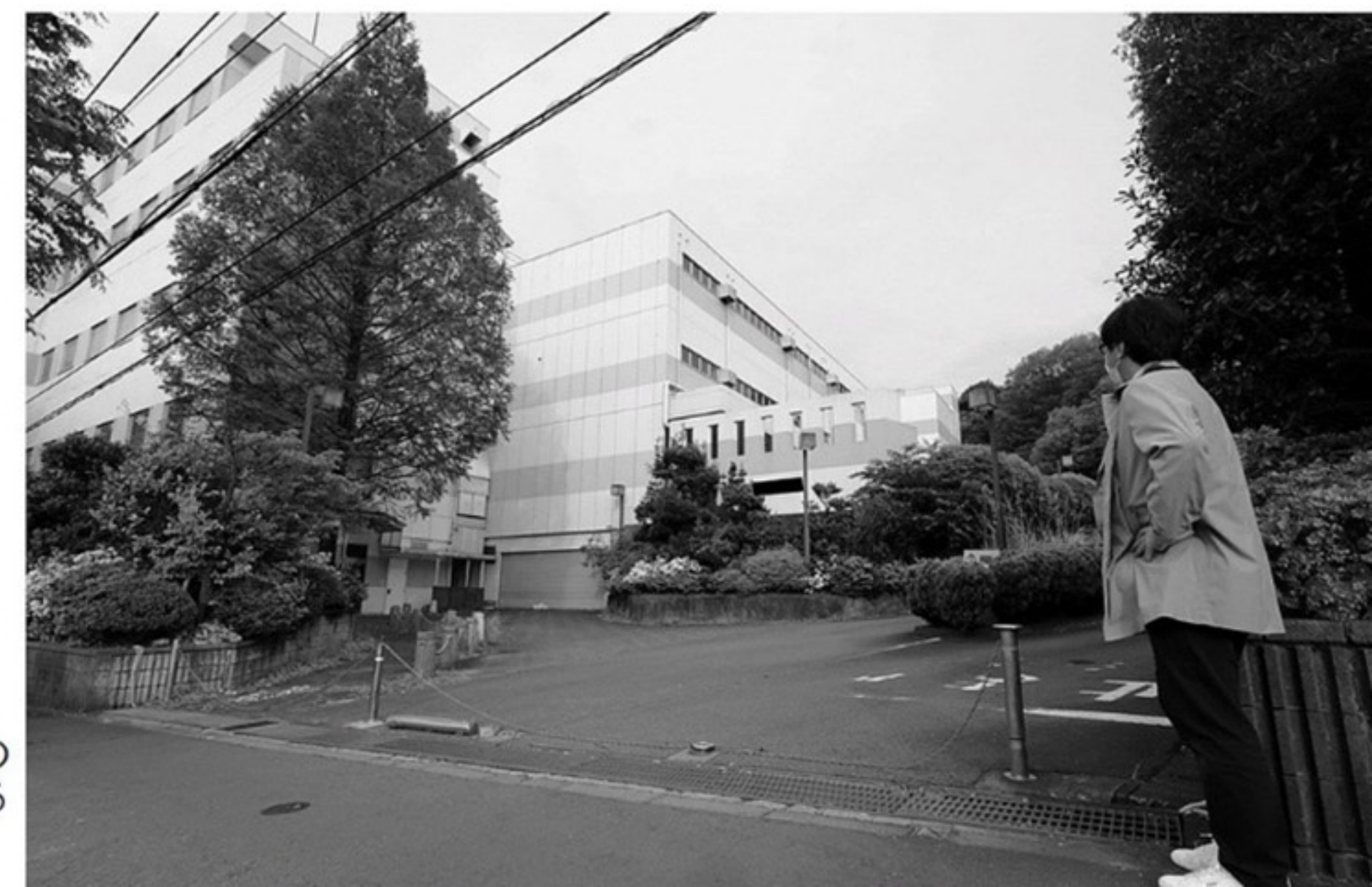
現地には、A社の本社工場の建物がそのまま残されている
